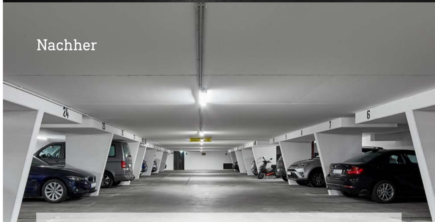
Im Vergleich zur Altbeleuchtung konnte eine um 30 % hellere Ausleuchtung aller Bereiche erzielt werden. Hierdurch gestaltet sich der Aufenthalt auf der Parkfläche angenehmer und das Sicherheitsempfinden der Nutzer verbessert sich. Gleichzeitig wird auch das Rangieren auf der Verkehrsfläche sicherer.
