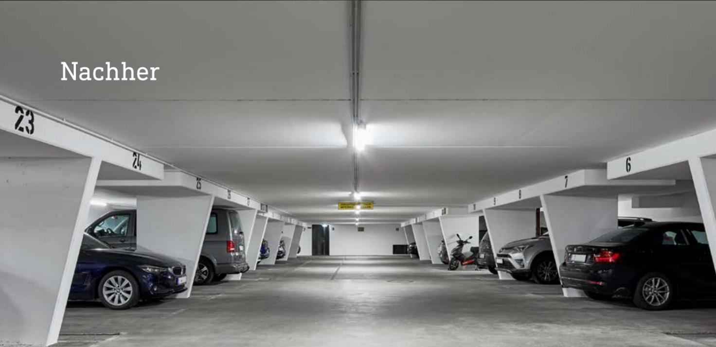
Im Vergleich zur Altbeleuchtung konnte eine um 30 % hellere Ausleuchtung aller Bereiche erzielt werden. Hierdurch gestaltet sich der Aufenthalt auf der Parkfläche angenehmer und das Sicherheitsempfinden der Nutzer verbessert sich. Gleichzeitig wird auch das Rangieren auf der Verkehrsfläche sicherer.
