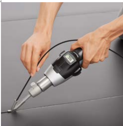
▼ Linoleumboden verschweißen HG 2620 E
