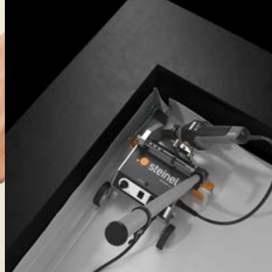
▲ Dachbahnen schweißen HG Roof two
