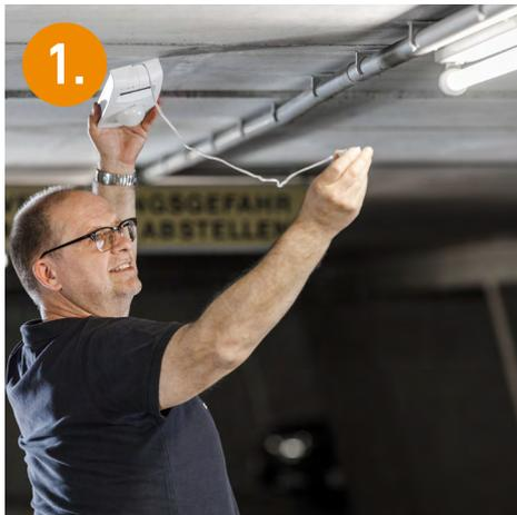
1. Die Installation und Inbetriebnahme des PROLog Messgeräts erfolgt durch einen unserer Installateure.
